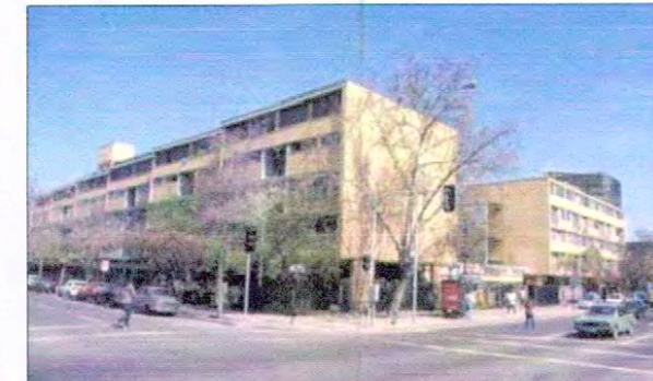
Vista Principal del Conjunto Habitacional Matta-Viel imagen de estado actual. Fuente: Consejo de Monumentos Nacionales
