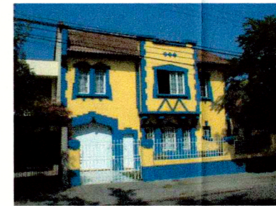
Fachada de una de las casas del conjunto
