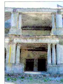
Detalle fachada de acceso.
