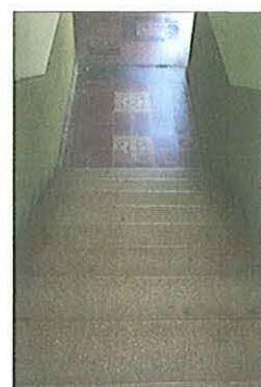
Vista de escalera interior
