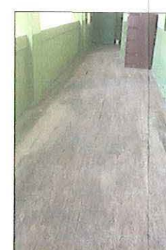
Vista de pasillo interior
