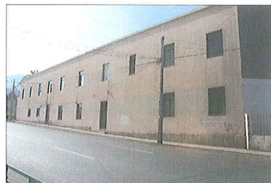
Vista de Fachada por calle Manuel Antonio Matta
