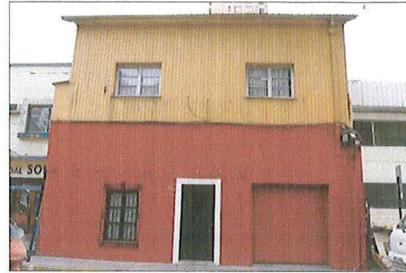
Vista fachada por calle Serrano
