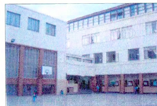
Cuerpo de fachada - Aula Magna - patio
