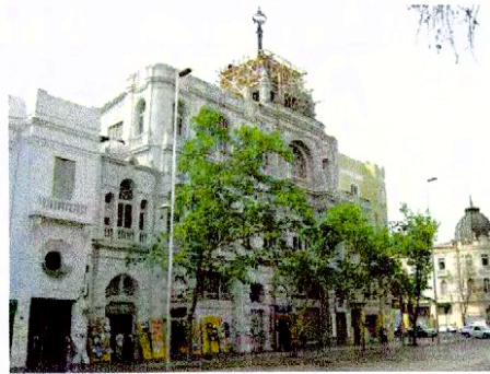
Vista fachada principal del palacio.
