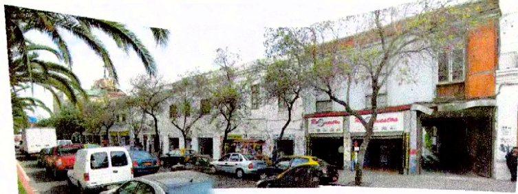
Vista desde Avenida Brasil hacia Alameda
