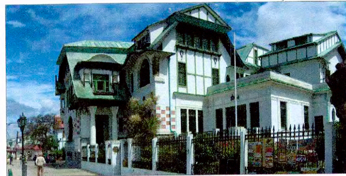
Vista fachada por paseo Yugoslavo
