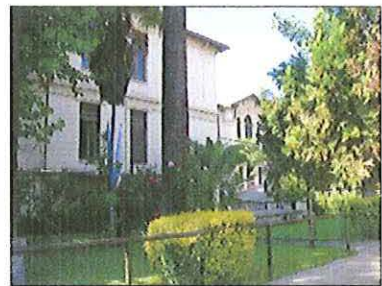
Vista panorámica del Pabellón Valentín Errázuriz.
