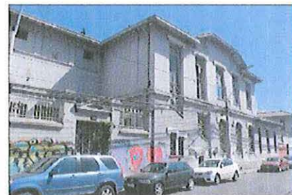
Vista panorámica de fachada norte del Pabellón Alejandro del Río.
