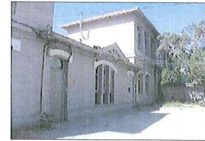
Fachada sur del Pabellón Alejandro del Río.
