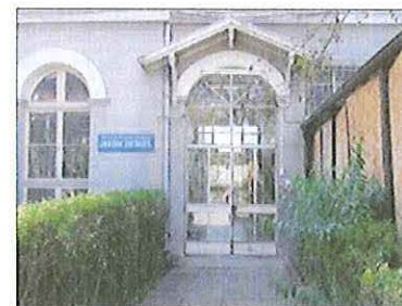
Fachada sur del Pabellón Alejandro del Río.
