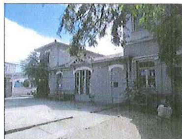
Fachada sur del Pabellón Alejandro del Río.
