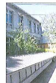
Fachada sur del Pabellón Alejandro del Río.
