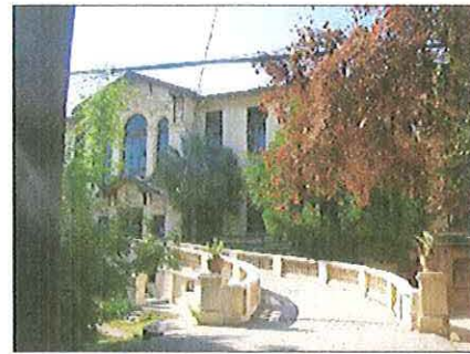
Acceso Pabellón Valentín Errázuriz
