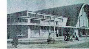
Vista hacia el norte por calle Caupolicán del edificio original.
