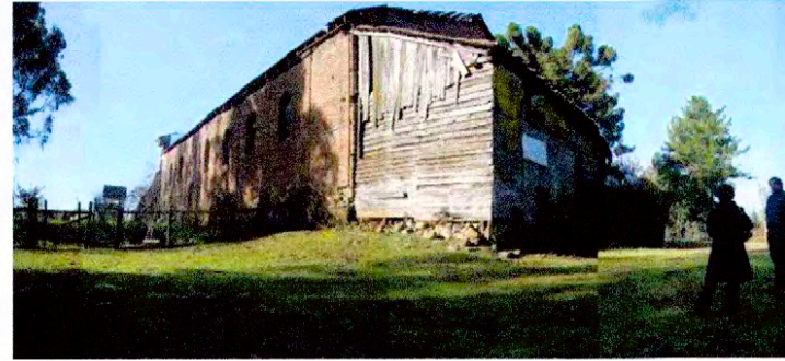
Vista parcial de fachadas nororiente y suroriente.
