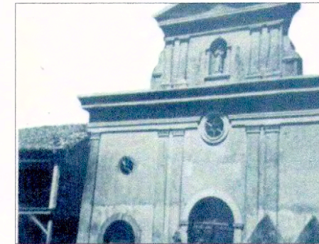
Imagen de la fachada de la iglesia con torre (desaparecida actualmente).
