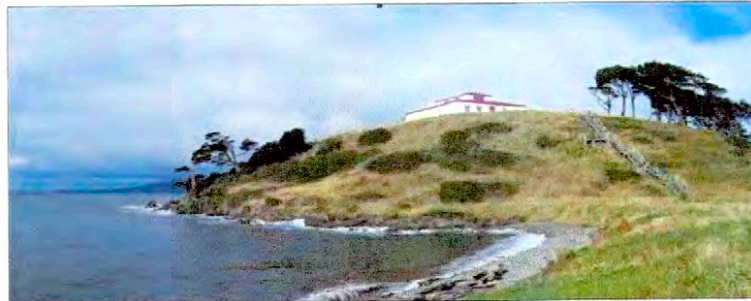
Vista del Faro San Isidro y su emplazamiento.
