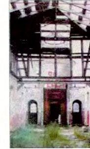
Interior Faro San Isidro en el año 1993.
