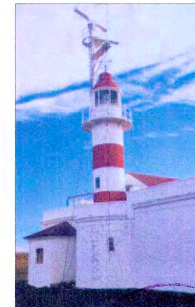
Vista de la linterna
