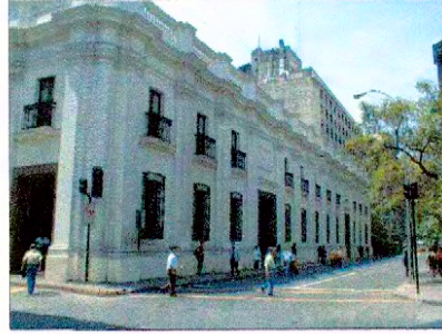
Fachada por calle Bandera.
