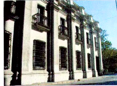
Fachada por calle Compañía.
