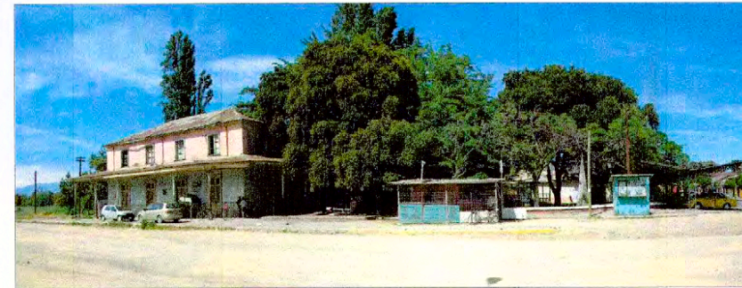
Vista de Estación de Peumo
