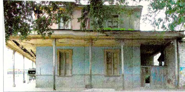
Vista lateral de Estación de Peumo
