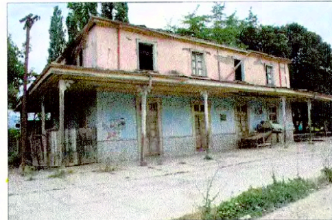
Vista fachada de Estación de Peumo
