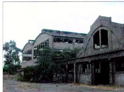
Talleres de Herrería y Calderería (3 y 2)
