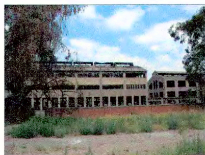
Talleres de Calderería y de Armadura (2 y 1)
