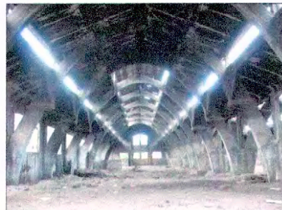
Vista interior del Taller de Herrería (3)
