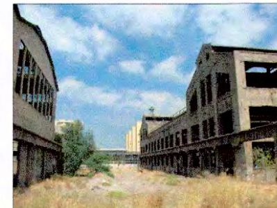
Vista general desde acceso actual
