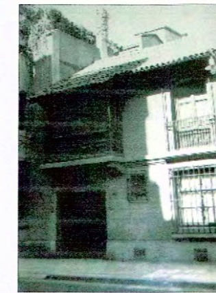
Fachada, fotografía año 1958
