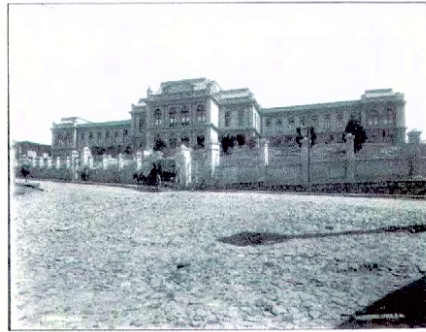
Vista estado original de fachada principal
