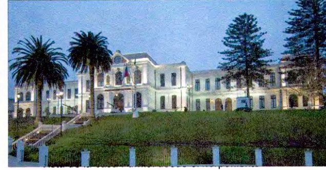
Vista estado actual de fachada principal
