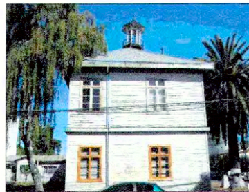
Fachada Calle Cruz.
