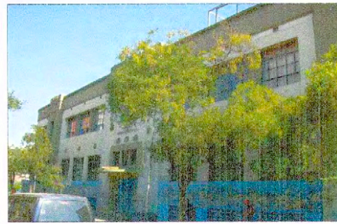
Vista del acceso por calle Nataníel Cox.
