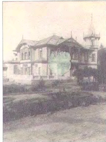
Fotografía de la casa recién construida.
