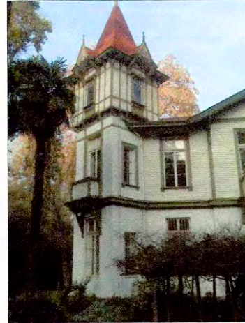
Detalle de la torre.
