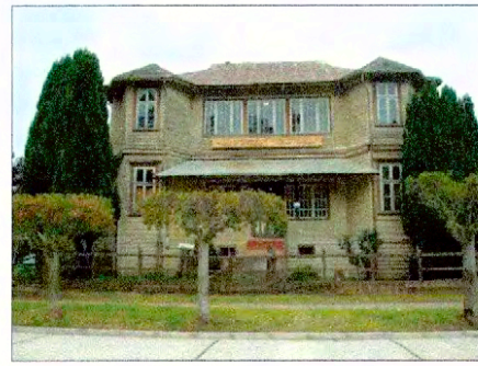
Vista fachada principal (oriente)
