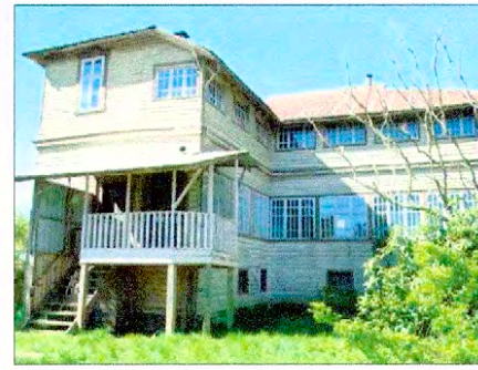
Vista fachada poniente
