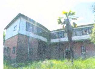
Vista parcial fachadas sur y poniente
