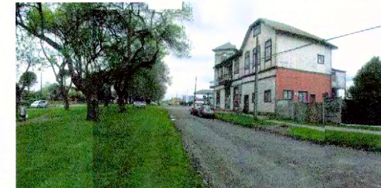
Vista norponiente desde Av. Balmaceda
