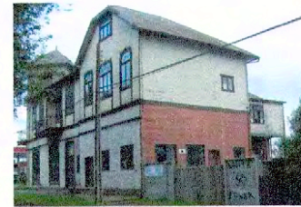
Vista parcial fachadas norte y poniente
