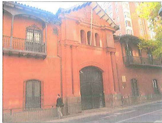
Fachada principal por Santo Domingo.
