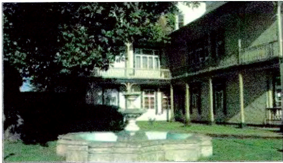
Vista pileta al interior de la casa (original)
