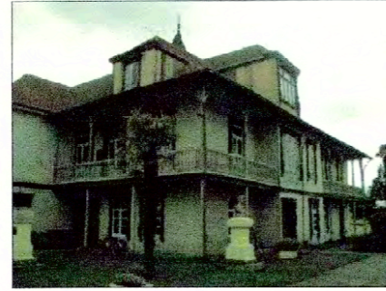
Vista parcial fachadas sur y oriente
