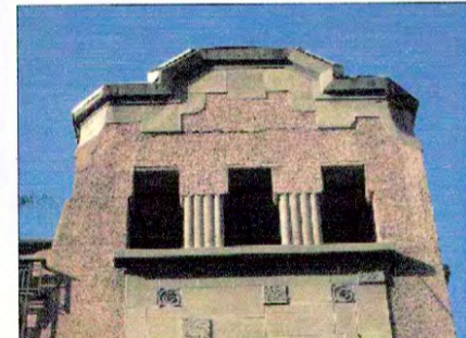
Detalle de remate superior torrecilla
