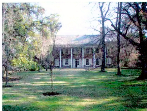
Fachada oriente, calle Américo Vesputio
