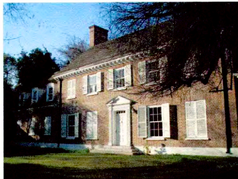
Fachada poniente, calle Asturias.
