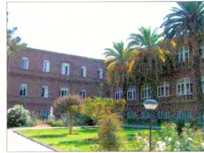
Vista fachada lateral
