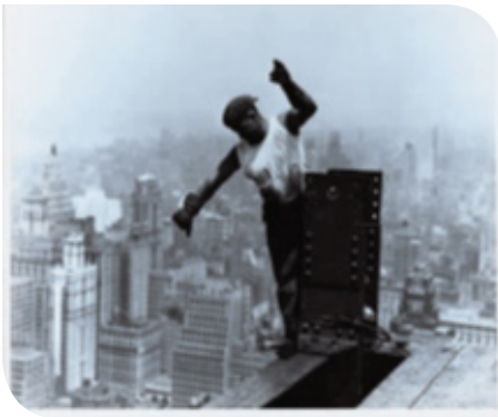
Obrero remachador en un rascacielos de Nueva York
