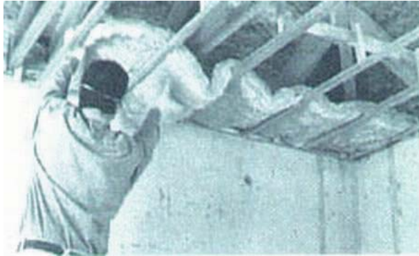
Figura 14 - 19: Colocación y despliegue del rollo de aislación de lana de vidrio o roca, entre los listones donde irán colocadas planchas de yeso del cielo.
