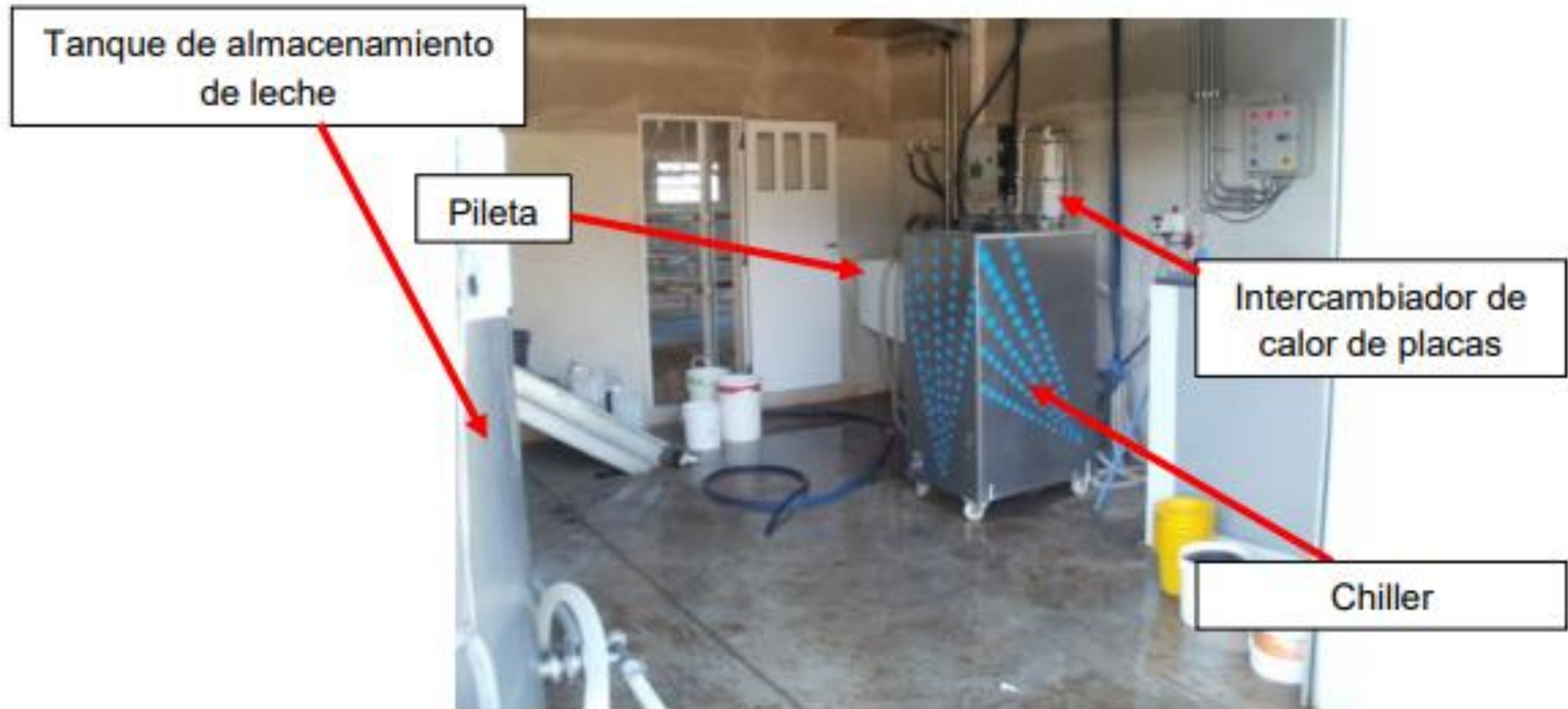
Equipos de refrigeración y almacenamiento de leche.
